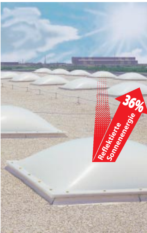
Hallenverglasung mit doppelschaligen Lichtkuppeln.
