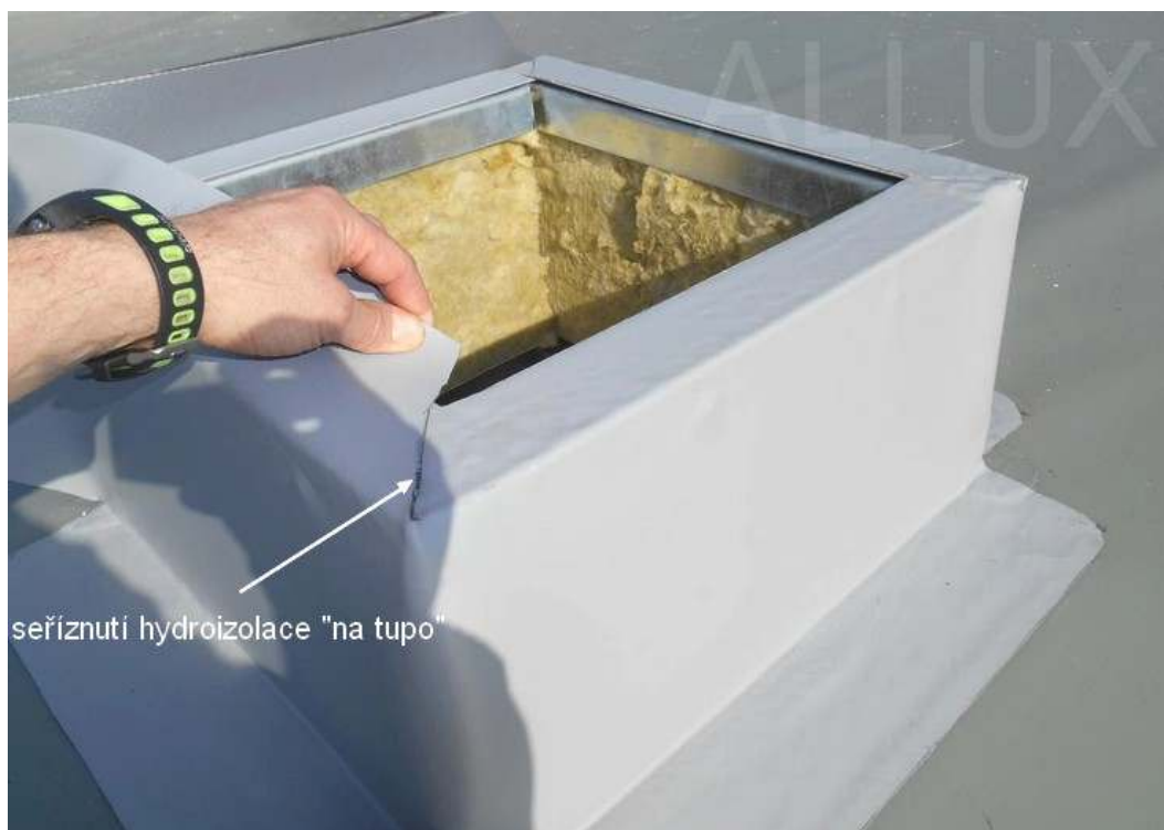
Obrázek č. 5 – kompletní zaizolování dosedací plochy podsady pro montáž Přechodového rámu ALLUX
