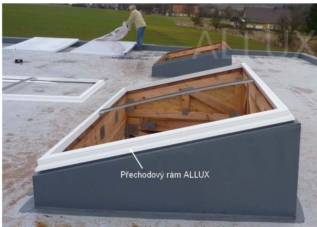
Obrázek č. 6: Montáž „Přechodového rámu ALLUX“
