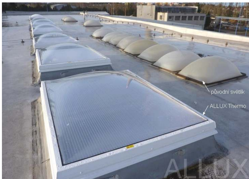
Obrázek č. 8: Montáž křídla ALLUX na přechodový rám (kopulové zasklení)
