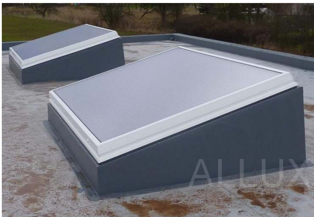
Obrázek č. 7: Montáž křídla ALLUX na přechodový rám (ploché zasklení PC deskou)
