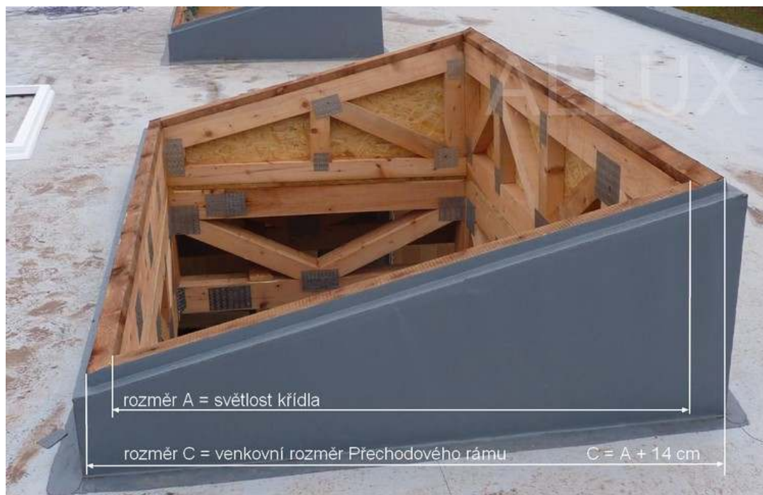
Obrázek č. 4: Rozměr A = vnitřní rozměr a rozměr C = vnější rozměr
