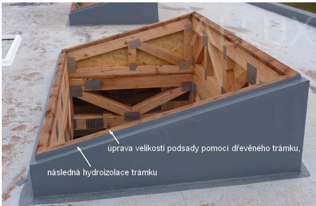
Obrázek č. 3: Úprava rozměrů horní hrany podsady pomocí dřevěného hranolu (trámku 50 x 60 mm)
