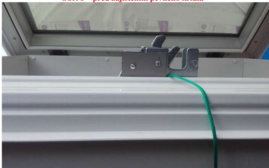
Obr. 8 – před zajištěním pevného křídla
